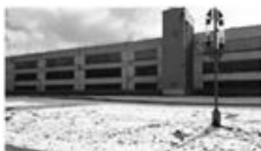
Общий вид и состояние сейчас.
