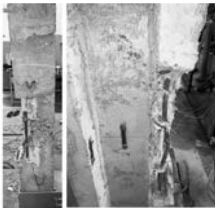
Рис. 5. Колонны после испытаний.
