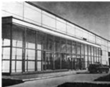
Рис. 1. Главный фасад текстильной фабрики г. Москва.
