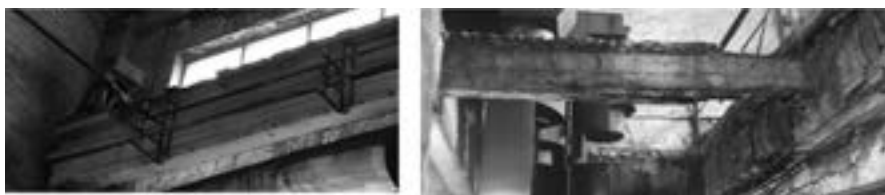
Рис. 1. Повреждения в железобетонных балках
