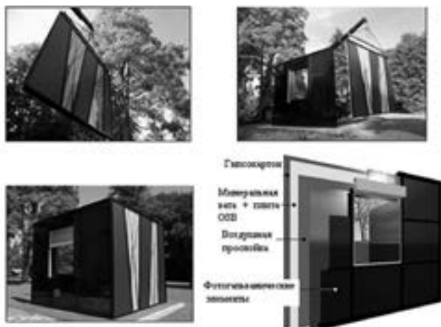
Рис. 3. Быстровозводимые здания с фотогальваническими модулями Faceactive.
