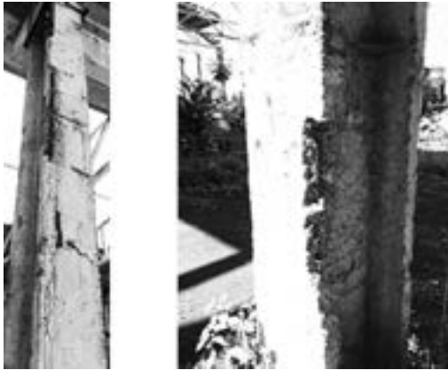
Рис. 1. Повреждение двутавровых колонн в процессе эксплуатации.
